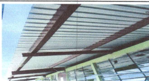
Foto 6: Sustrucción de costaneras de metal por de metal
