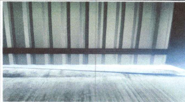
Foto 4: Sustrucción de lamina, por lamina troquelada aluzinc calibre 26 en establecimiento
