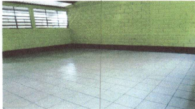
Foto 2: Sustrucción de piso de torta de concreto por piso ceramico ( aulas y corredor)
