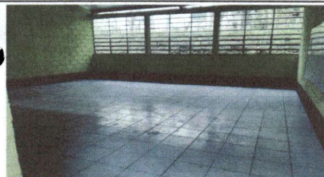
Foto 5: Sustrucción de piso torta de concreto por piso ceramico en aulas
